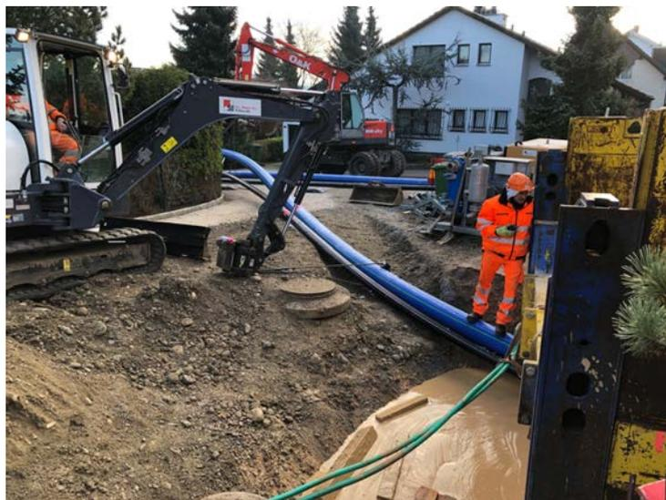
Einzug Wasserleitung und Kabelschutzrohr durch Pressvortrieb Haldenweg-Reservoir Rehweg. *Albert Boutellier, Mai 2020*
