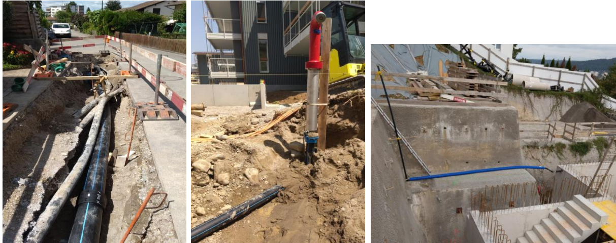
Neue Hydranten und Rohrlegearbeiten. Raphael Baumann
