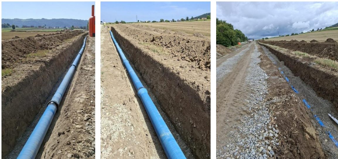
Leitungsbau Furttal. Raphael Baumann
