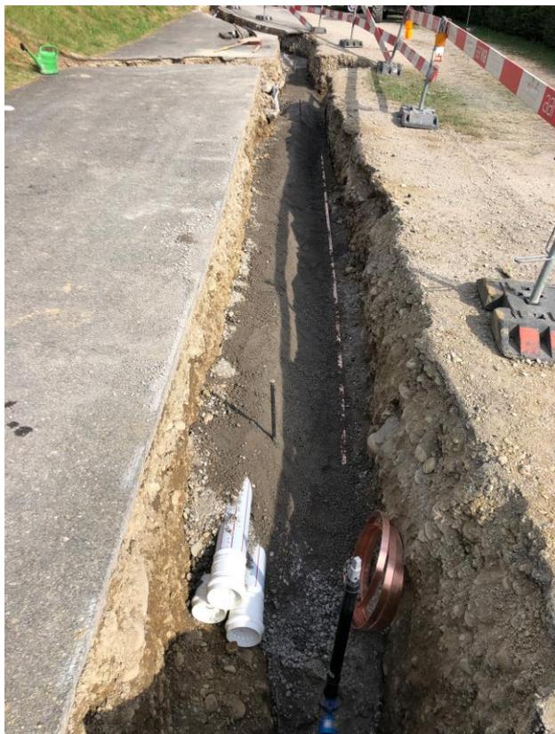
Erschliessung Buckmatte, Wasserschieber, EW-Rohre und Erdband. *Albert Boutellier*
